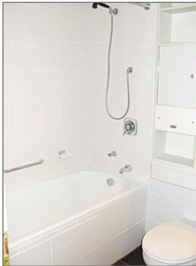
Renoviertes Bad im Hotel
