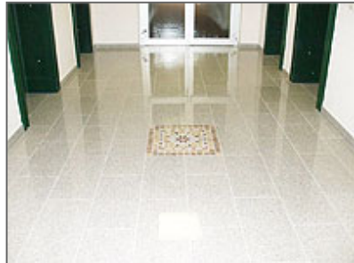
Bürolobby auf jedem Stockwerk
