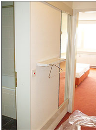
Hotelzimmer während der Renovierung
