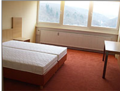
Hotelzimmer während der Renovierung
