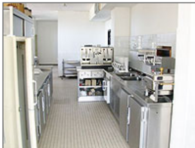
Küche im 19. Stock vor der Renovierung
