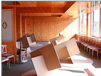
Restaurant im 20. Stock während der Renovierung
