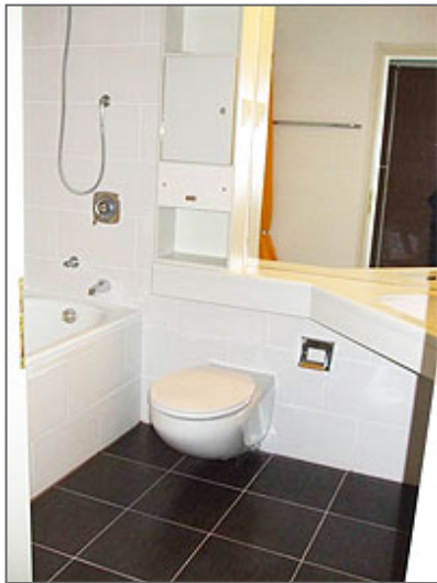
Renoviertes Bad im Hotel
